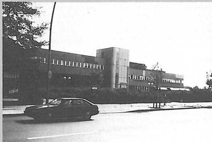
Kaputte Stadt durch öffentliche Bauten: Beispiel Mittelstufenzentrum...
